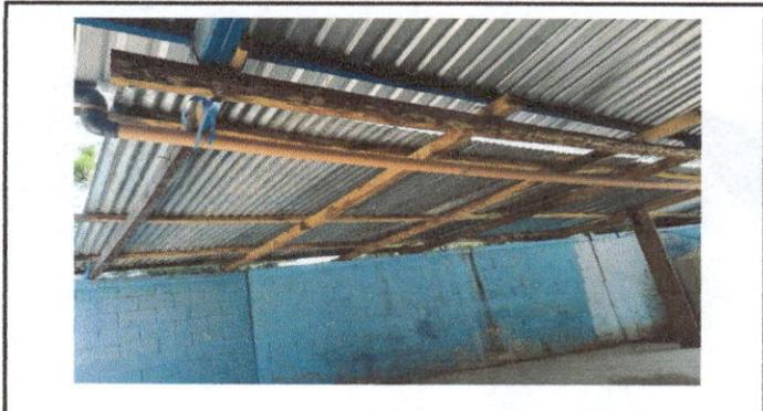
Foto 4: Sustitución de estructura de madera por metal y la lámina
